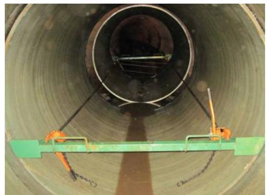
Стеклопластиковые трубы Helyx соединяются путем захода гладкого конца одной трубы в раструб другой. Герметизация стыка осуществляется за счет наличия широкого резинового кольца специальной формы в клееного в паз раструба, обеспечивающие высокую водонепроницаемость и эластичность трубного соединения.
