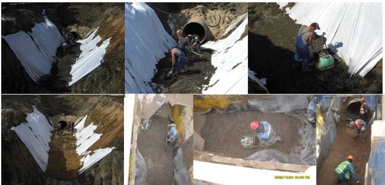
Рис 48 Устройства оснований под трубы
