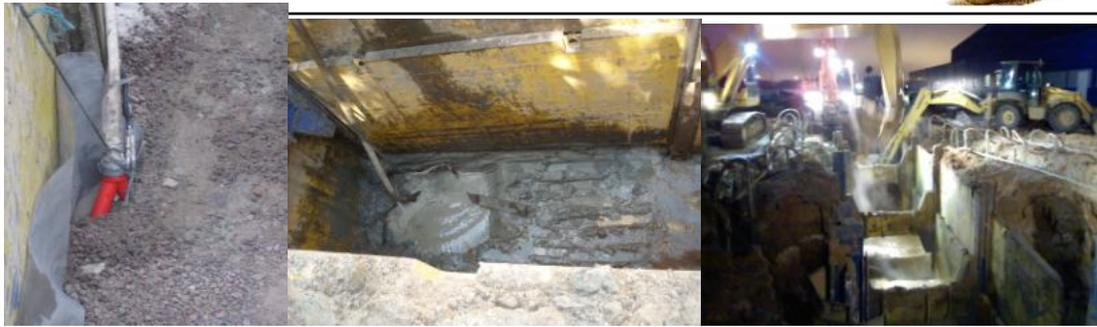
Рис 45 Водоотлив из траншеи
