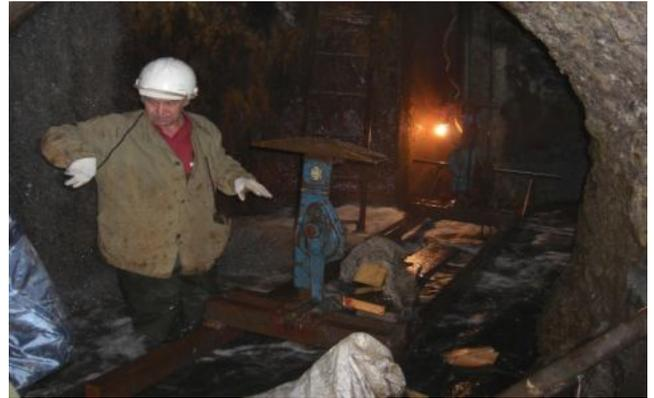
Рис. 23 Тележка для транспортировки и установки труб
