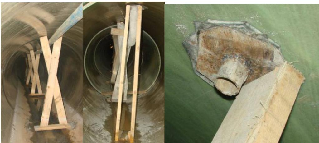
Для предотвращения всплытия и деформации труб при заполнении межтрубного пространства раствором желательно заполнить трубопровод водой.
