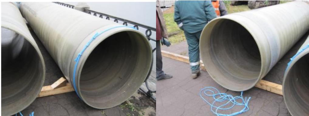
*Рис 43 Складирование труб на площадке*
