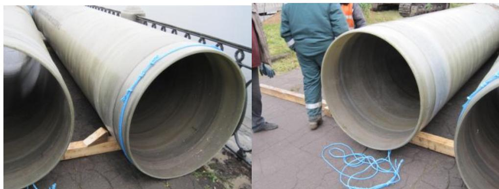
*Рис 43 Складирование труб на площадке*
