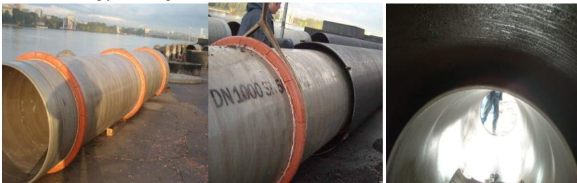
Способ протаскивания трубы в трубе
