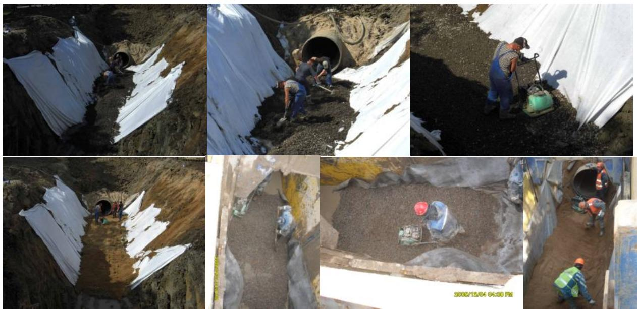
*Рис 48 Устройства оснований под трубы*
