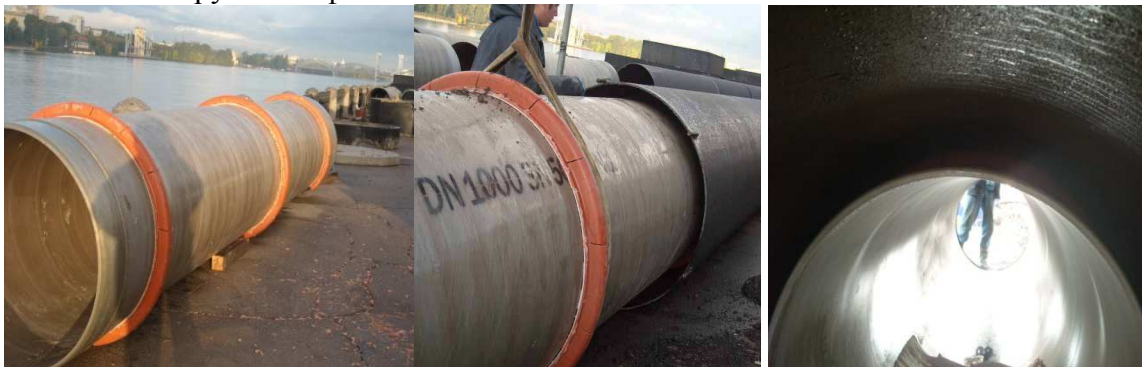
Способ протаскивания труба в трубе
