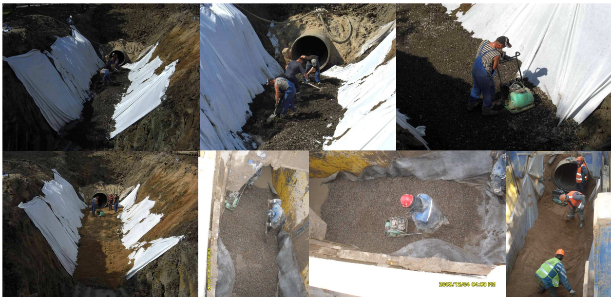
Рис 31 Устройства оснований под трубы
