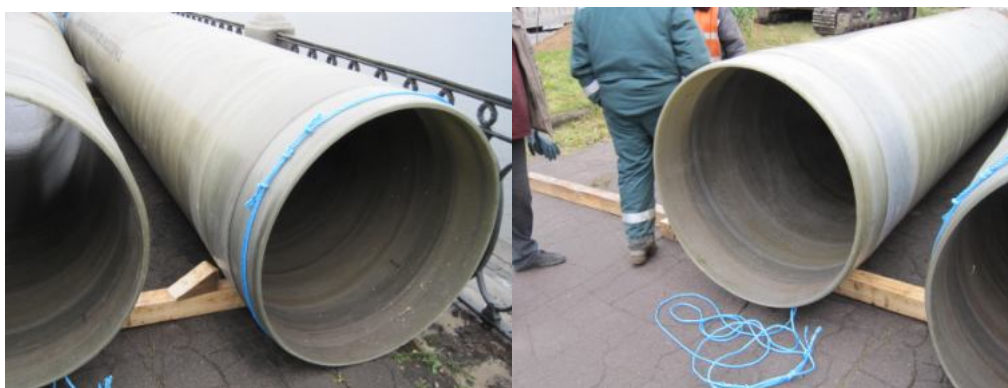
Рис 43 Складирование труб на площадке
