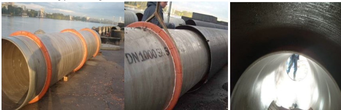
Способ протаскивания труба в трубе
